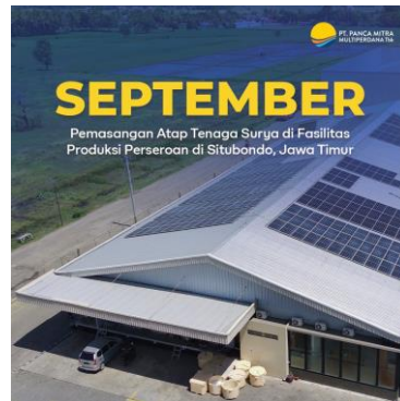
Pemasangan Atap Tenaga Surya
